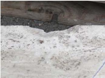
Bild 16 - Ausbruch im Bereich der Ankerdome (Platte wurde ausgetauscht)
